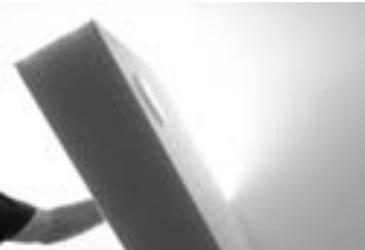
Montage mit Heiß- und Montagekleber
