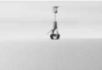
Montage mit Steckblech als preiswerte Alternative
